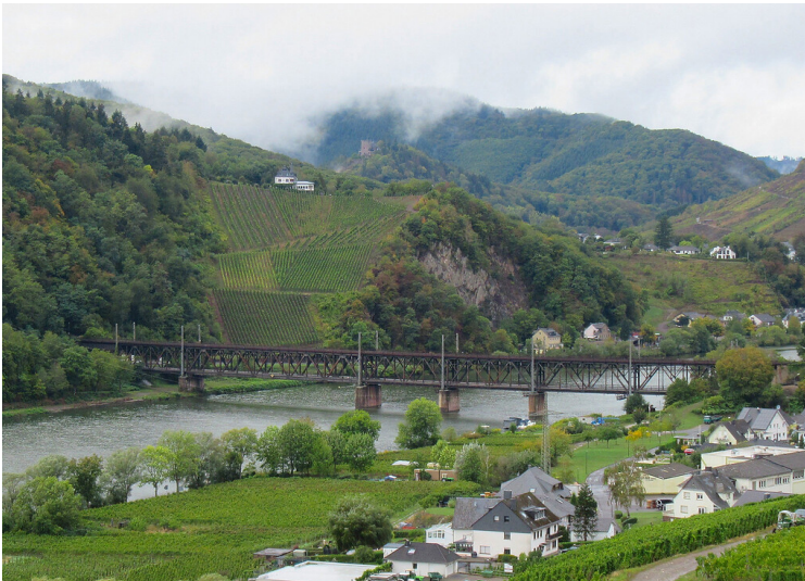
Blick von Bullay aus über die Mosel und die Bullayer Doppelstockbrücke in Richtung Alf und der im Hintergrund sichtbaren Burg Arras (2020). Fotograf/Urheber: Michael Grün
