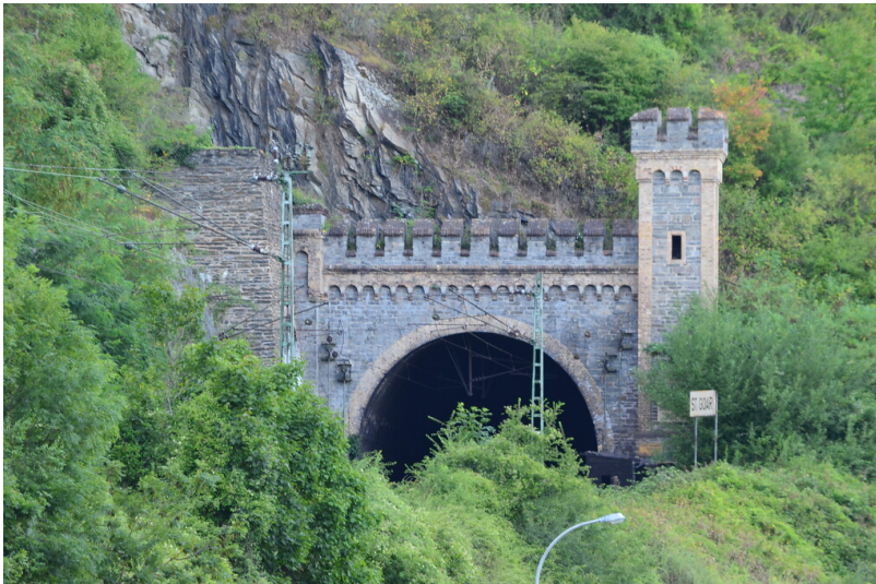
Südportal am Banktunnel in Sankt Goar (2015) Fotograf/Urheber: Kira Bublies
