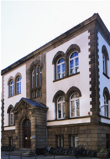
Die Alte Bibliothek der RWTH Aachen, Wüllnerstraße 3, in Aachen (2011). Fotograf/Urheber: Jürgen Gregori
