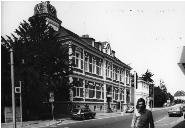
Postamt Wülfrath, Wilhemstraße 82 (1978) Fotograf/Urheber: Roswitha Neu-Kock
