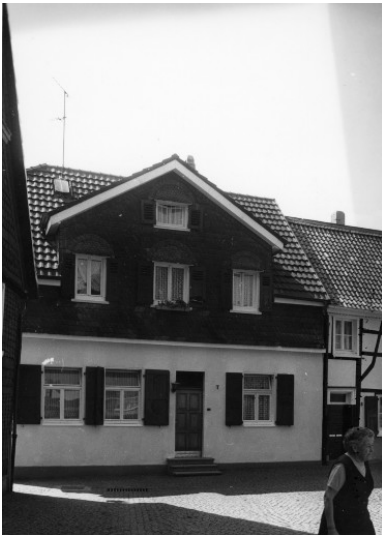
Wohnhaus Leye, Kirchplatz 7 in Wülfrath (1978) Fotograf/Urheber: Roswitha Neu-Kock
