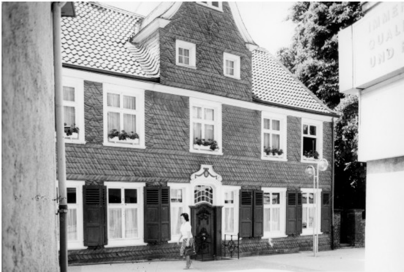
Wohnhaus Zum goldenen Engel, Wilhelmstraße 159 in Wülfrath (1978) Fotograf/Urheber: Roswitha Neu-Kock
