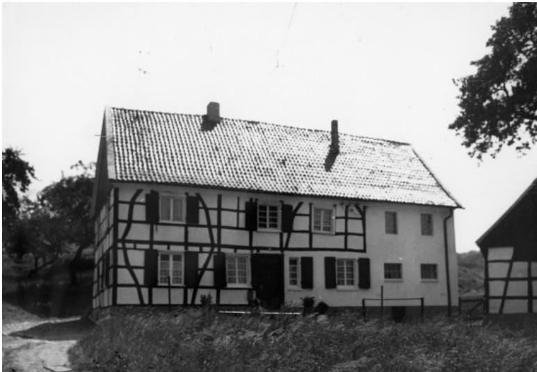
Gut Huppenkothen, Nord-Erbach 52 in Wülfrath (1978) Fotograf/Urheber: Frances Sturm
