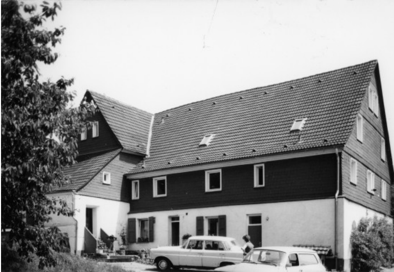
Gut Frickenhaus, Nord-Erbach 25 in Wülfrath (1978) Fotograf/Urheber: Frances Sturm
