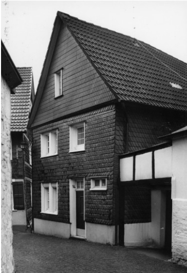
Fachwerkwohnhaus Hechtshaus, Kirchplatz 16 in Wülfrath (1978) Fotograf/Urheber: Roswitha Neu-Kock
