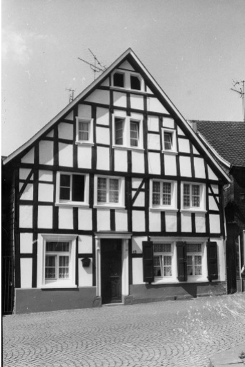
Fachwerkwohnhaus Frythof, Kirchplatz 13 in Wülfrath (1978) Fotograf/Urheber: Roswitha Neu-Kock
