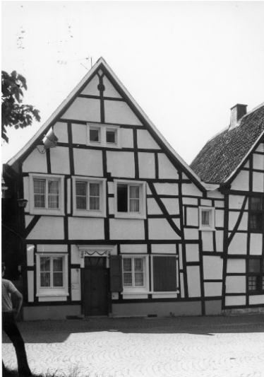
Fachwerkwohnhaus "Aufm Haus", Kirchplatz 9 in Wülfrath (1978) Fotograf/Urheber: Roswitha Neu-Kock
