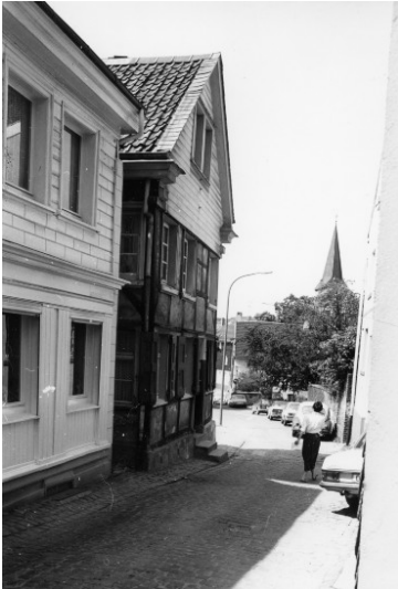
Wohnhaus Bleek, Heumarktstraße 9 in Wülfrath (1978) Fotograf/Urheber: Roswitha Neu-Kock
