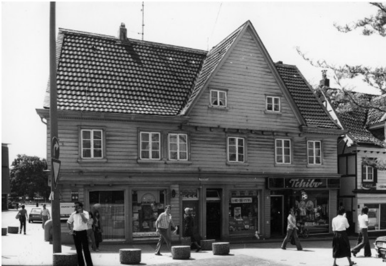
Wohn- und Geschäftshaus Müllersgehen, Heumarktstraße 1 in Wülfrath (1978) Fotograf/Urheber: Roswitha Neu-Kock
