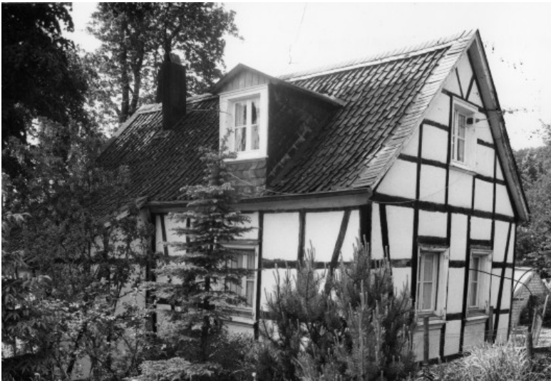
Fachwerkwohnhaus Gut Langensiepen, Diakonissenweg 13 in Wülfrath-Schlupkothen (1978) Fotograf/Urheber: Frances Sturm
