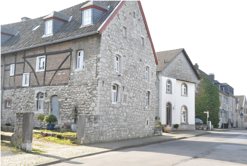
Historischer Straßenzug in Alt-Breinig in Stolberg mit Bauernhäusern aus Bruchstein, teilweise mit Fachwerkelementen (2014). Fotograf/Urheber: Fine Tonhauser
