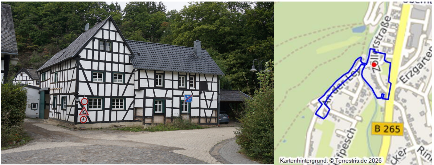
Hellenthal, Denkmalbereich Oberhausen (2022). Fachwerkwinkelhof Fotograf/Urheber: Claus Weber
