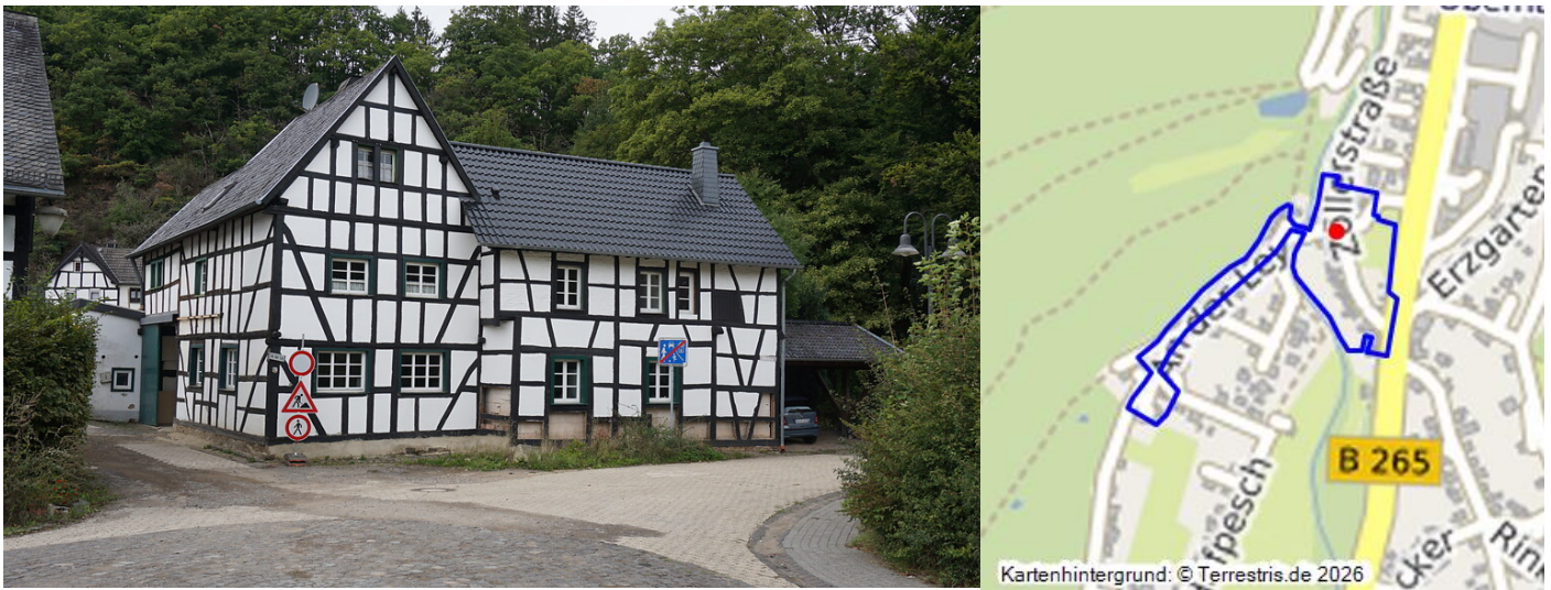
Hellenthal, Denkmalbereich Oberhausen (2022). Fachwerkwinkelhof Fotograf/Urheber: Claus Weber
