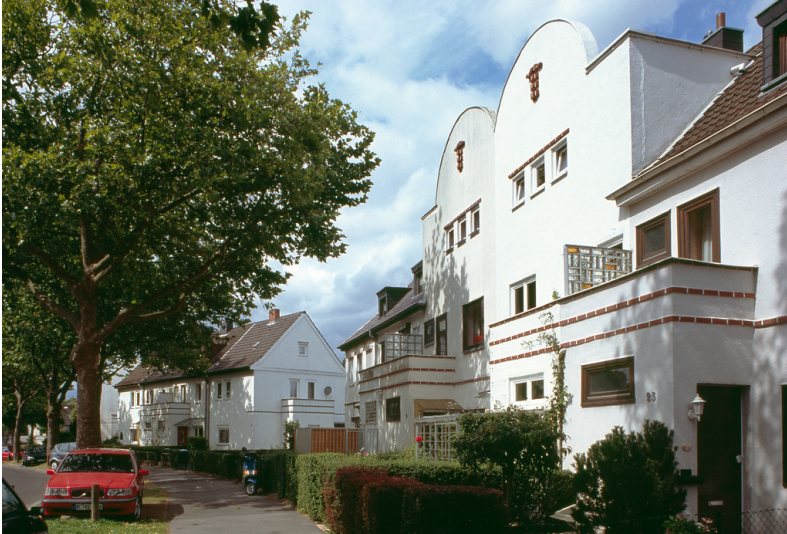
Aachen-Burtscheid, Denkmalbereich Siedlung In den Heimgärten / Branderhof Fotograf/Urheber: Jürgen Gregori
