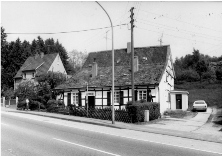
Fachwerkwohnhaus, Schlupkothen 5 in Wülfrath (1978). Fotograf/Urheber: Frances Sturm
