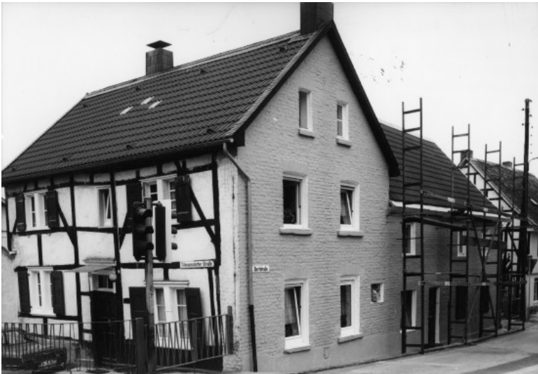
Fachwerkwohnhaus, Tillmannsdorfer Straße 27 in Wülfrath-Düsseldorf (1978) Fotograf/Urheber: Frances Sturm
