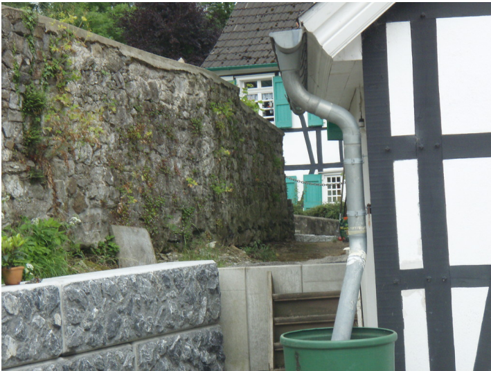
Umfassungsmauer Kirchhof Düsseldorf (2009) Fotograf/Urheber: Axel C. Welp
