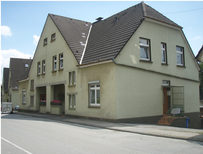
Wülfrath-Rohdenhaus, Am Kliff 24-54, Arbeitersiedlung Rohdenhaus (2009) Fotograf/Urheber: Stadt Wülfrath - Untere Denkmalbehörde
