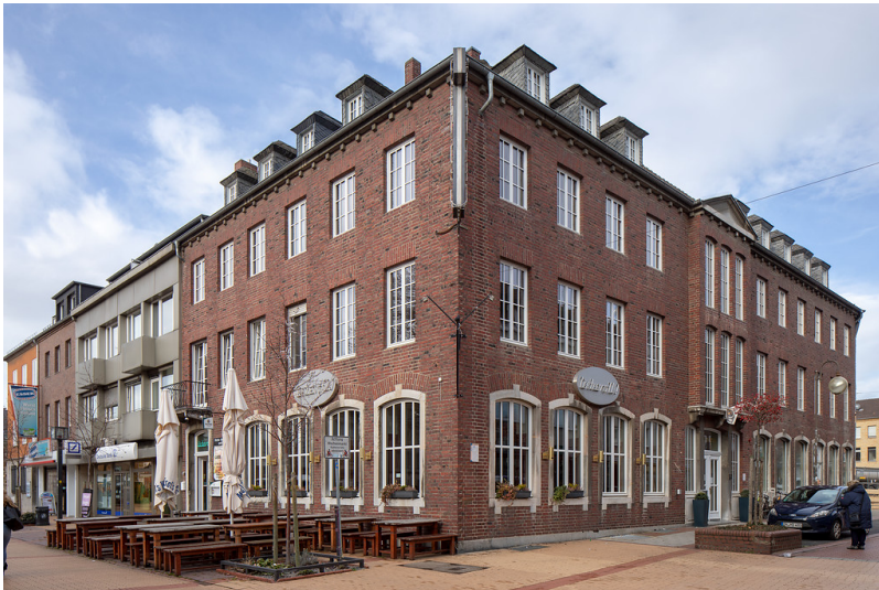
Jülich, Kölnstraße 5, ehemaliges Hotel Kratz Fotograf/Urheber: Silvia Margrit Wolf
