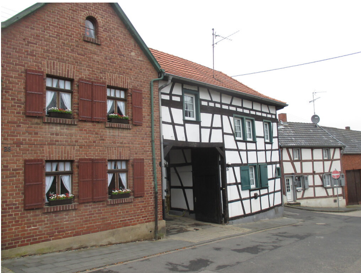
Dreiseithof aus Fachwerk und Klinkergebäude in Lommersum (2015) Fotograf/Urheber: Annette Schwabe
