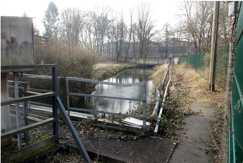
Stau- und Wehranlagen am Abzweig des Troisdorfer Mühlengrabens von der Agger, im Hintergrund Teile des früheren Hüttenwerks Friedrich-Wilhelms-Hütte, heutige Mannstaedt-Corus GmbH (2017). Fotograf/Urheber: Franz-Josef Knöchel
