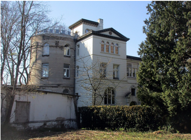
Frühere Werksanlagen der Friedrich-Wilhelm-Hütte im Bereich der Josef-Kitz-Straße unweit des "Kasino-Viertels" in Troisdorf-Friedrich-Wilhelms-Hütte (2020). Fotograf/Urheber: Franz-Josef Knöchel
