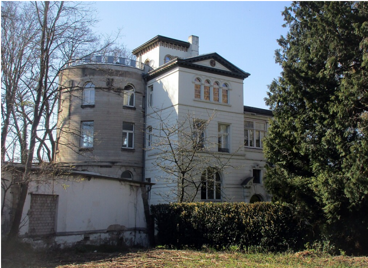
Frühere Werksanlagen der Friedrich-Wilhelm-Hütte im Bereich der Josef-Kitz-Straße unweit des "Casino-Viertels" in Troisdorf-Friedrich-Wilhelms-Hütte (2020). Fotograf/Urheber: Franz-Josef Knöchel
