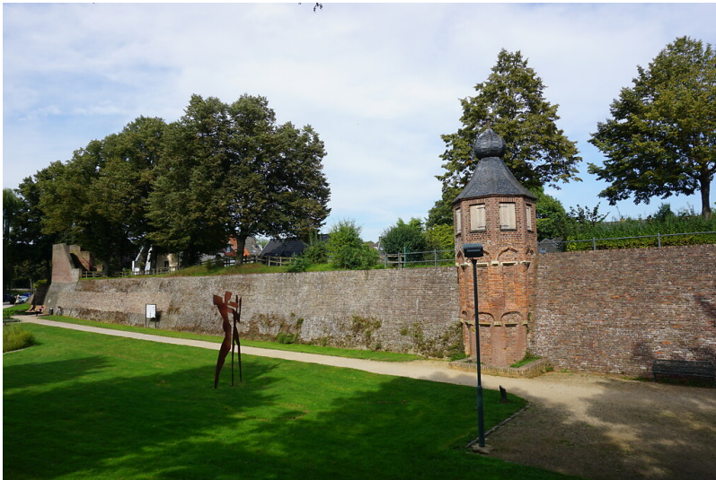
Rees. Partie der Festungsanlage im Südwesten der Stadt mit Wächerturm (vorn) und Weißem Turm (hinten) (2021) Fotograf/Urheber: Claus Weber
