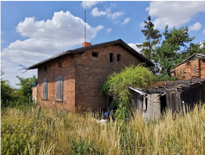
Stellwerk nahe Edderitz - Wohngebäude in Stellwerksnähe Fotograf/Urheber: NAME FEHLT
