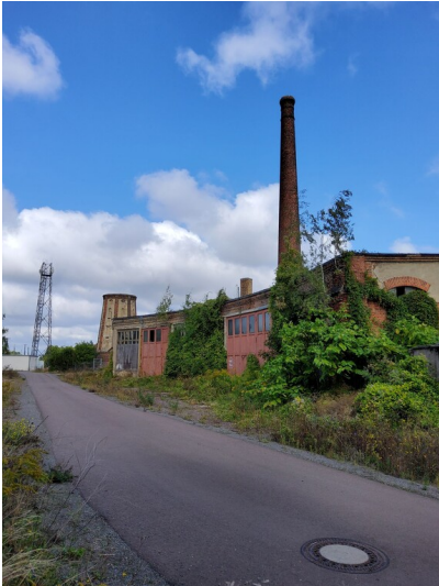
Bahnbetriebswerk Köthen Fotograf/Urheber: NAME FEHLT
