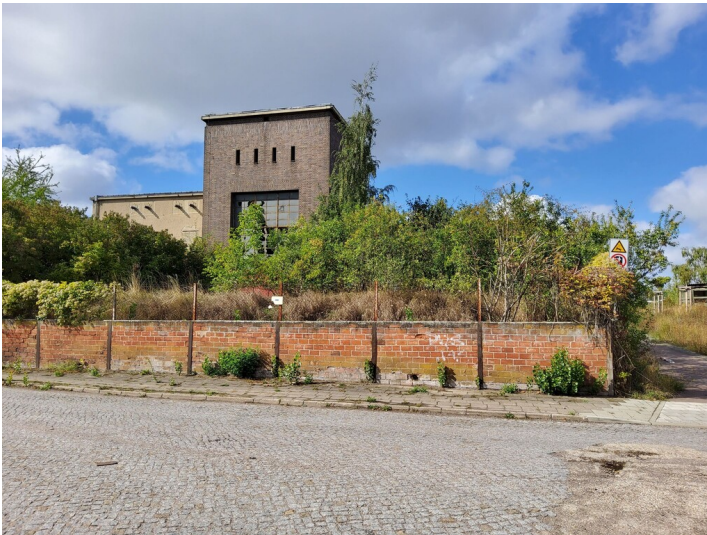
Eisenbahn-Umspannwerk Köthen Fotograf/Urheber: NAME FEHLT
