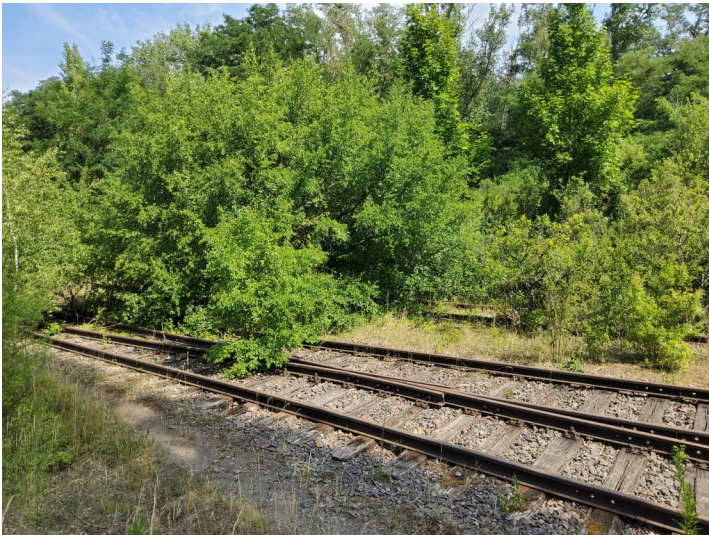
Edderitzer Industriebahn der Grube Leopold - Im Waldstück hinter dem Kulturhaus sind die Schienen auf langer Strecke erhalten Fotograf/Urheber: NAME FEHLT
