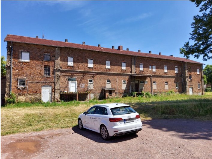
Ledigenwohnheim ""Kaschemme"" der Solvay-Werke - straßenabgewandte Gebäudeseite Fotograf/Urheber: NAME FEHLT
