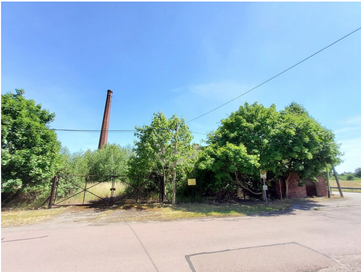
Standort Brikettfabrik Micheln, Trebbichau - Blick von Westen Fotograf/Urheber: NAME FEHLT
