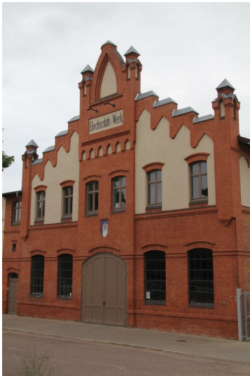
Elektrizitätswerk Aken (Elbe) Fotograf/Urheber: NAME FEHLT
