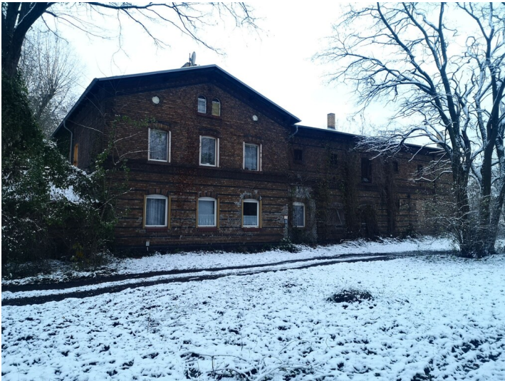
Standort Greppiner Werke - Gebäude Werkshof Nr. 1 Fotograf/Urheber: NAME FEHLT
