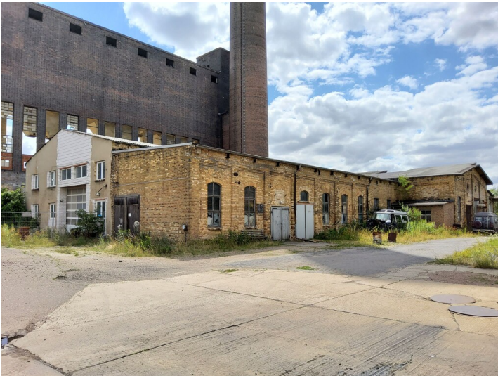
Kraftwerk Bitterfeld - Blick in Richtung Südwesten auf Teile des Kraftwerks und den Schornstein Fotograf/Urheber: NAME FEHLT
