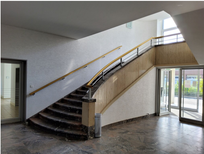
Metall-Labor Dr. Adolf Beck - Details aus Leichtmetall (Handläufe, Türen) Fotograf/Urheber: NAME FEHLT
