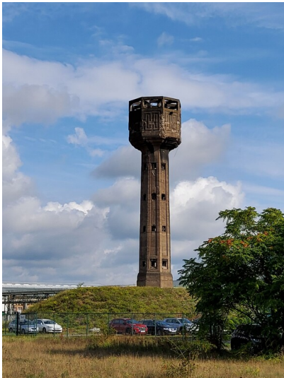
Chemische Fabrik Griesheim-Elektron und Folgeunternehmen - Wasserturm am ehemaligen Kraftwerksstandort Fotograf/Urheber: NAME FEHLT
