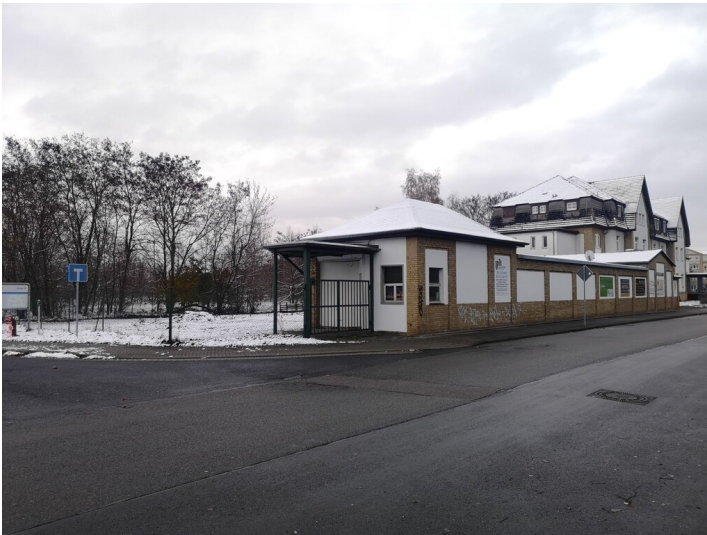
Altstandort AGFA - Eingangsbereich der ersten AGFA-Fabrikteils in Greppin (um 1910) Fotograf/Urheber: NAME FEHLT
