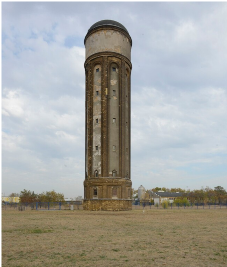
Wasserturm der Agfa Filmfabrik Fotograf/Urheber: NAME FEHLT
