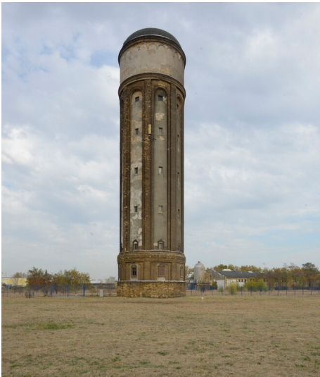
Wasserturm der Agfa Filmfabrik Fotograf/Urheber: NAME FEHLT
