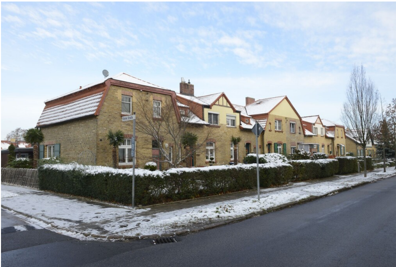
Werkssiedlung Agfa Abschnitt I Fotograf/Urheber: NAME FEHLT
