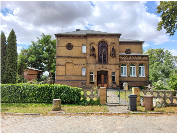
Fabrikantenvilla Roitzsch Fotograf/Urheber: NAME FEHLT
