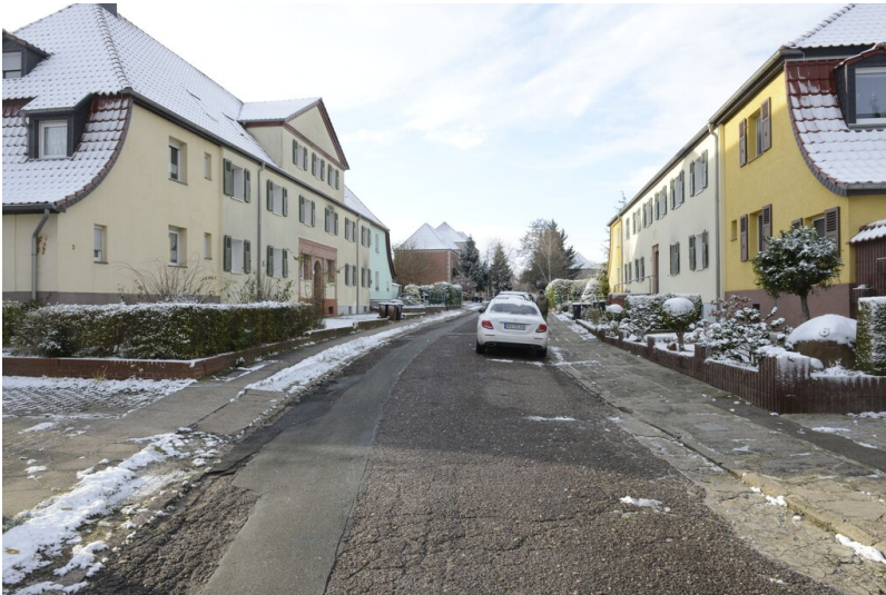
Kraftwerkssiedlung Bitterfeld - Brüder-Lang-Straße Fotograf/Urheber: NAME FEHLT
