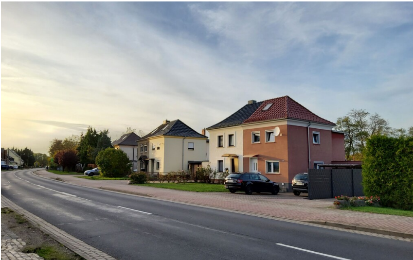
Siedlung "Am Bergmannswinkel" - entlang der Zörbiger Straße nach Westen Fotograf/Urheber: NAME FEHLT
