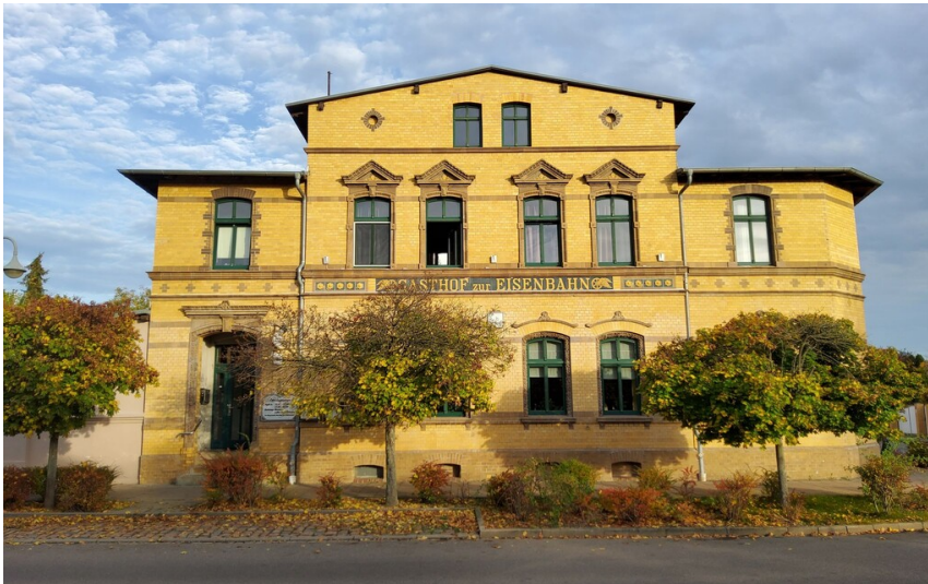
Gasthof "Zur Eisenbahn" - Fotograf/Urheber: NAME FEHLT
