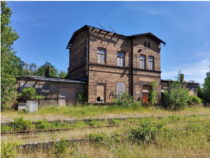
Bahnhof Trebbichau - Westfassade zur Bahnstrecke hin gelegen Fotograf/Urheber: NAME FEHLT
