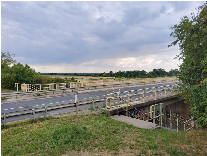
Muldestausee Einlaufbauwerk - Blick nach Norden Fotograf/Urheber: NAME FEHLT
