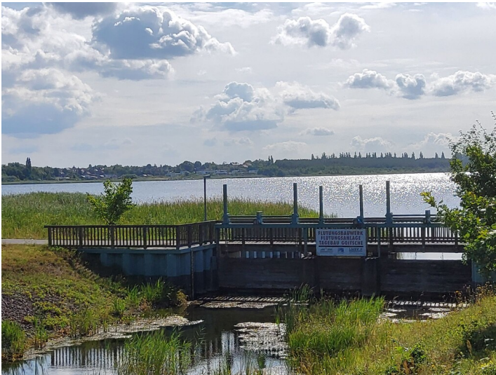
Flutungsbauwerk Tagebau Goitzsche - Mit Blick über die Goitzsche Fotograf/Urheber: NAME FEHLT
