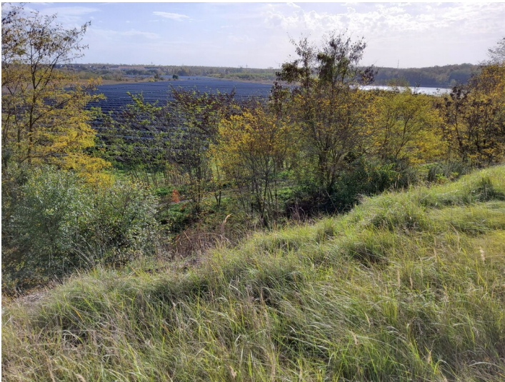
Tagebau Freiheit IV - Der Tagebau diente nach Stilllegung als Deponie und wurde somit wieder verfüllt, in jüngster Zeit wurde im Solarfeld darauf errichtet Fotograf/Urheber: NAME FEHLT
