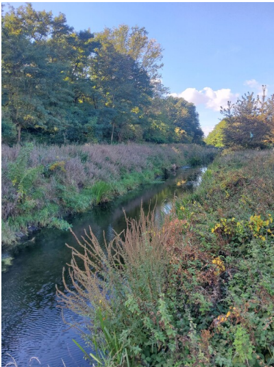
Umverlegung Strengbach - Der hoch eingedämmte, umverlegte Strengbach mit linearem Verlauf Fotograf/Urheber: NAME FEHLT
